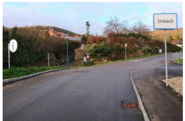
Der betroffene Kreuzungsbereich Kieslingstraße – Platzl – Kellergasse in Imbach, von der Kieslingstraße in Richtung Norden gesehen. In dieser Fahrtrichtung gibt es keinerlei Einschränkungen.
