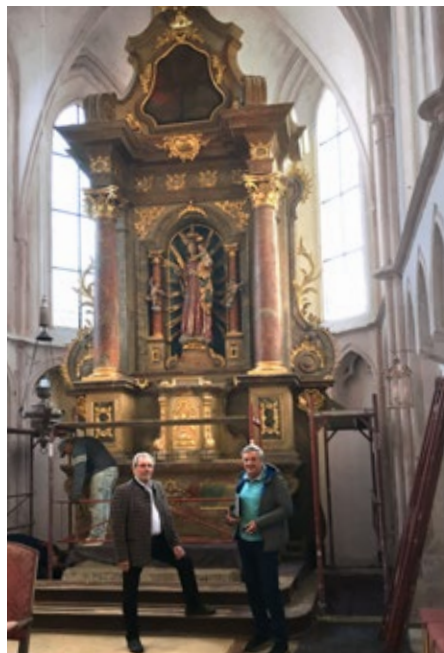
Mit dem Aufstellen der Gerüste konnten die Vorbereitungsarbeiten zur Renovierung im November beginnen.
