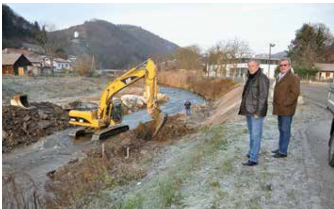
Bgm. Karl Steger und Vbgm. Helmut Pilz überzeugen sich vom Fortschritt der Hochwasserschutz-Arbeiten am Kremsfluß in Imbach.
