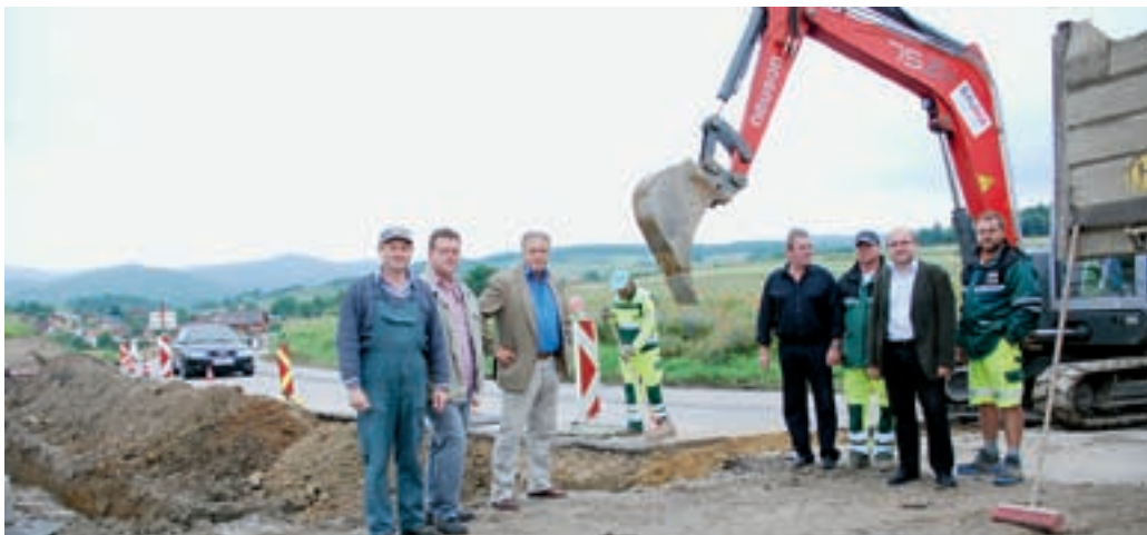
Die Aufschließungsarbeiten sind voll im Gange. Bgm Karl Steger, VBgm Helmut Pilz, GGR Josef Ott, GR Markus Grafinger und Ing. Reinhard Mair überzeugten sich vor Ort vom Baufortschritt.
