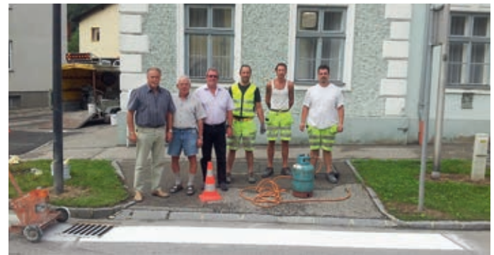
Auf Anregung des Elternvereines wurden bezüglich „Sicheren Schulweg“ die Fußgängerübergänge mit neuem Anstrich versehen.
