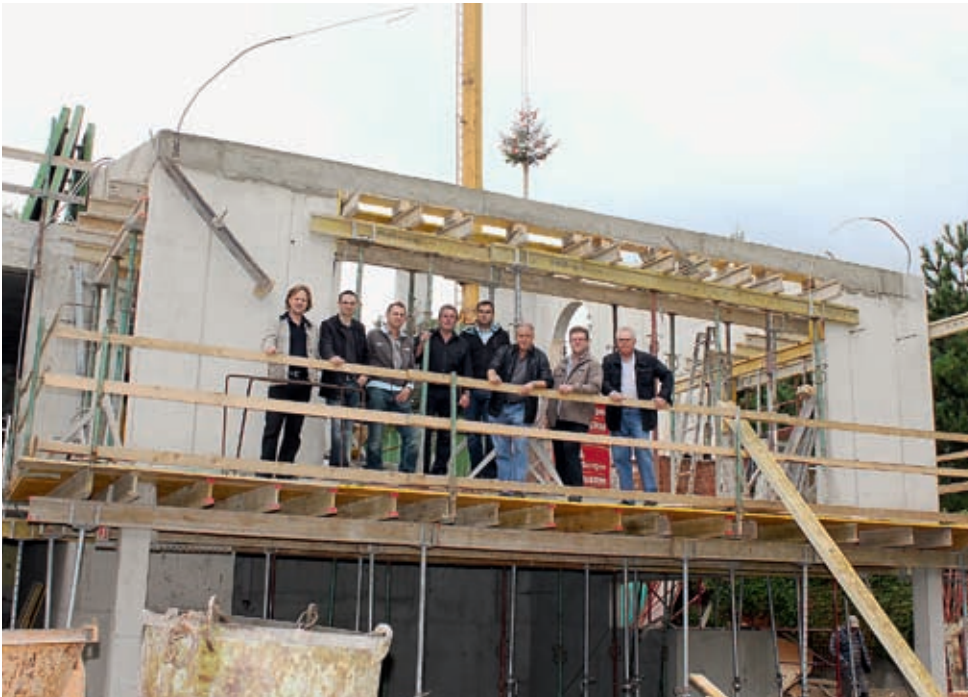
Zügig schreiten die Arbeiten am Kindergartenzubau voran.
