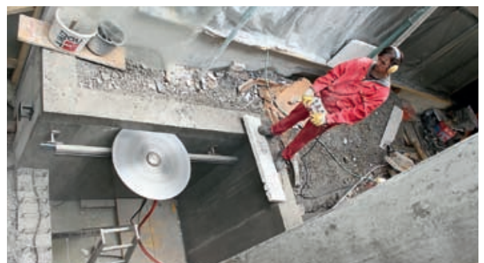
Betonschneidearbeiten
