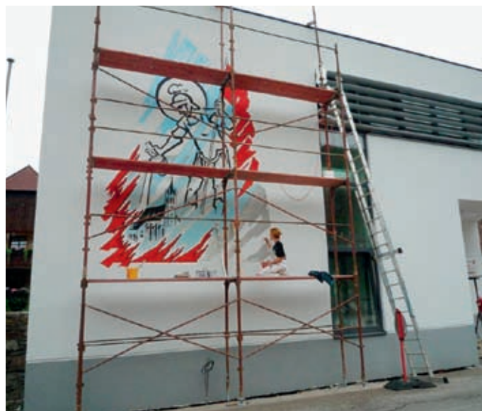
„Lüftmaler“ Kargl bei der Fassadengestaltung
