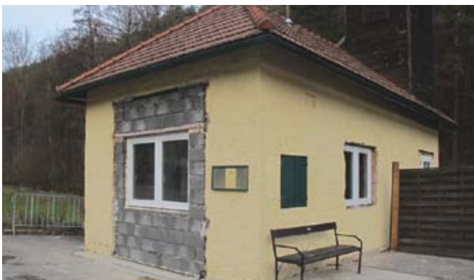
Der Umbau nimmt Gestalt an.
