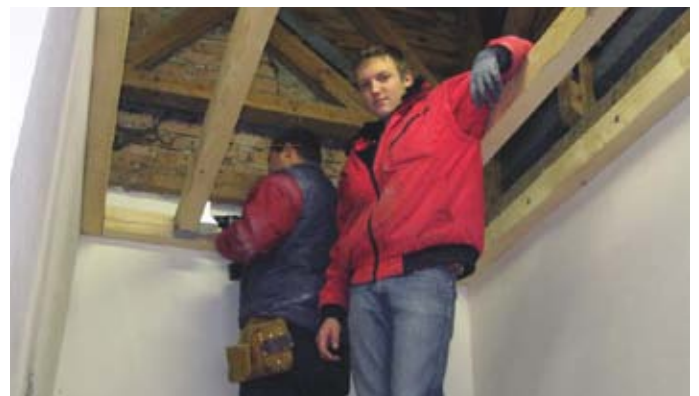
Ausbauarbeiten als Eigenleistungsanteil.
