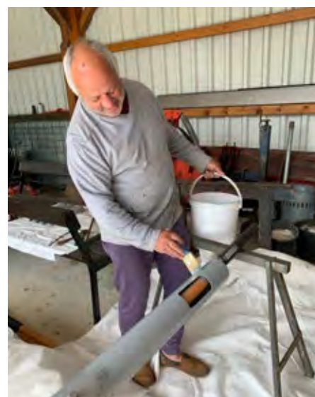
Die Lampensteher für die Zufahrtsstraße wurden restauriert.
