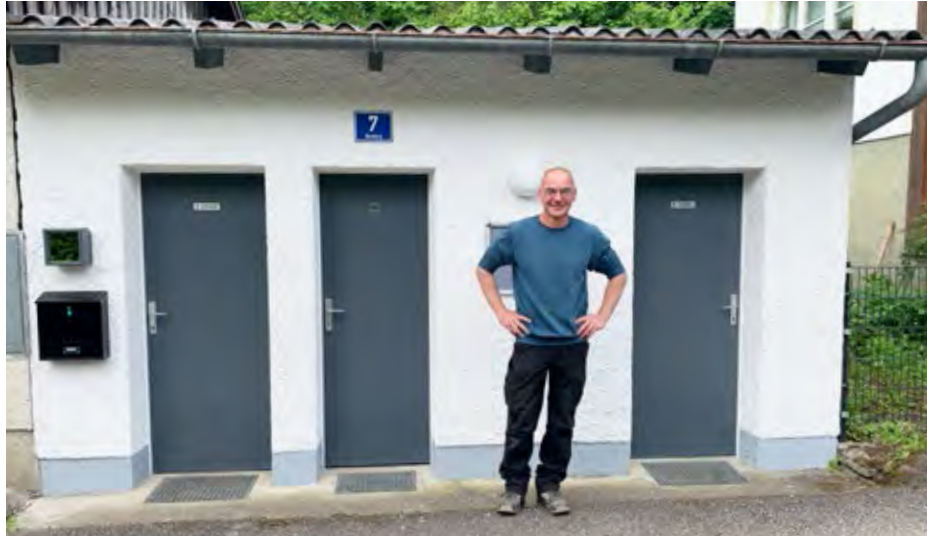
Auch die Sanitäranlagen wurden wieder auf den neuesten Stand gebracht. Tolle Arbeit haben Bauhofmitarbeiter Christian Pruckner und seine KollegInnen geleistet.
