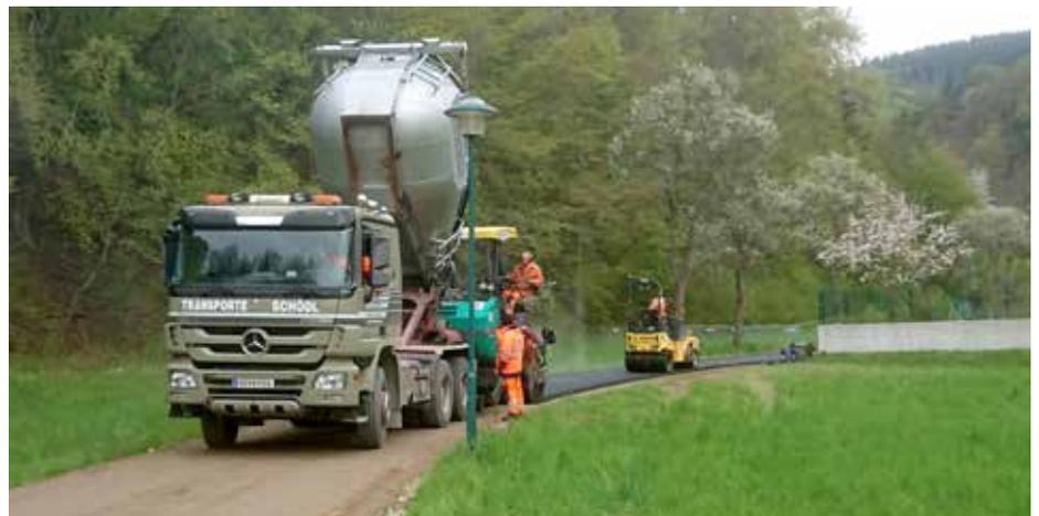
Der Güterweg Reicheck wurde zum Teil vollflächig asphaltiert, zum Teil wurden Betonfahrstreifen angelegt, damit Oberflächenwasser versickern kann.
