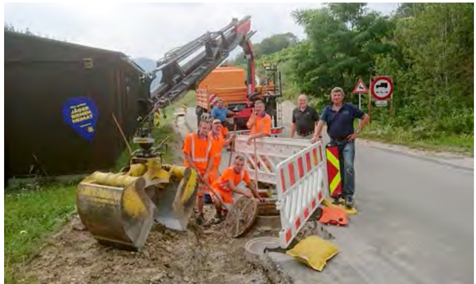
Straßenmeister Peter Heindl (r.) und Vizebürgermeister Karl Gruber (2. v. r.) mit Mitarbeitern der Straßenmeisterei Krems im Bereich der Baustelle auf der L 7078 zwischen Priel und Senftenberg, wo umfangreiche Straßenbauarbeiten und Maßnahmen zur besseren Ableitung der Oberflächenwässer umgesetzt wurden.
