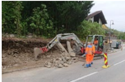
Steinmauersanierung in Unterm Hals.
