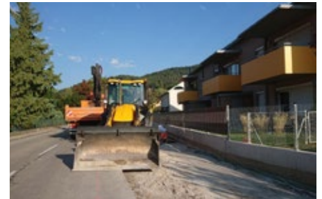
Neuer Markt: Gehsteig und Parkplätze.
