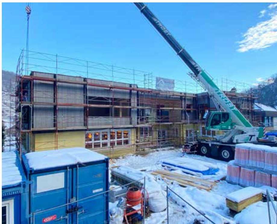
Die Arbeiten am Kindergartenzubau gehen zügig und termingerecht voran.
