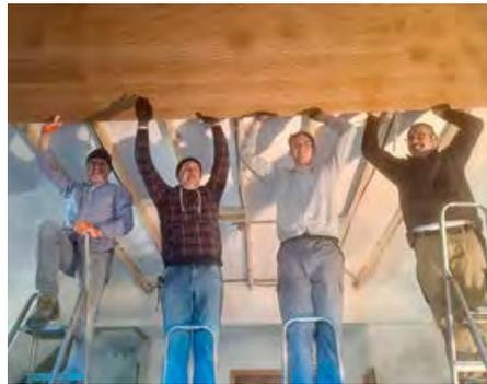
direkten Zugang von der Fahrzeughalle in den allgemeinen Bereich, ersetzt nun eine Dachgaube im Mehrzweckraum des Obergeschosses die vormaligen Dachflächenfenster. Ebenso wurde bereits eine Akustikdecke montiert und die Beleuchtung erneuert. Die bisherigen Arbeiten
